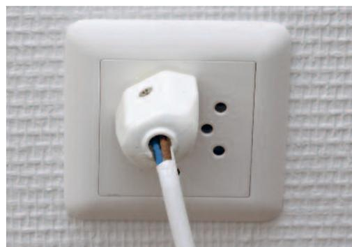
Fig. 22: Sostituire prontamente i cavi elettrici difettosi.
